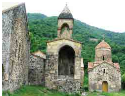
Рис. 1, 2. Сооружения монастыря Худаванг после «реставраций» во время оккупации
